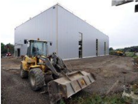
Großbaustelle von Eco-Terra im Gewerbegebiet West. Foto: Martin Weis
